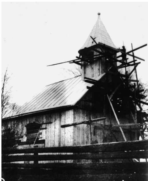
Baigiamieji koplyčios statybos darbai. 1929 11 20. VKM nuosavybė
