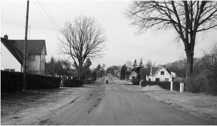
Pilviškių miestelio Birutės gatvė prieš asfaltavimą. 2017 m. V. Judicko nuotr.
